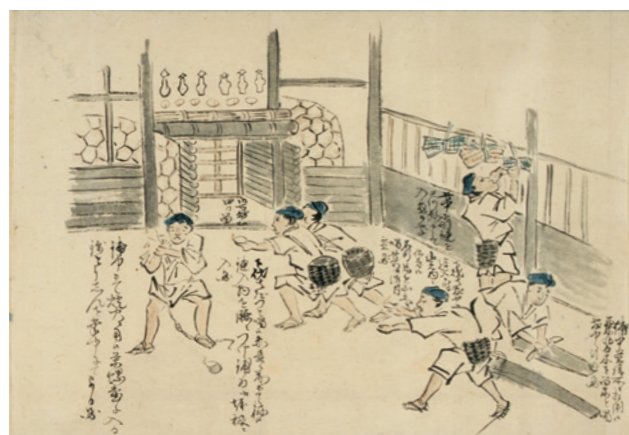
坑道入口での準備
