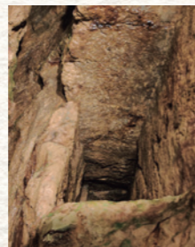
株式会社シルバー生野 (史跡・生野銀山) 提供 ノミの跡の残る坑道内 四角く掘られた坑道内には、江戸時代のノミの跡が見られる。
