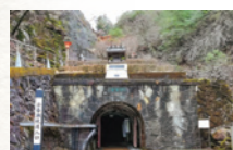
株式会社シルバー生野 (史跡・生野銀山) 提供 アーチ状石積の坑道入口 (金香瀬坑道入口)
