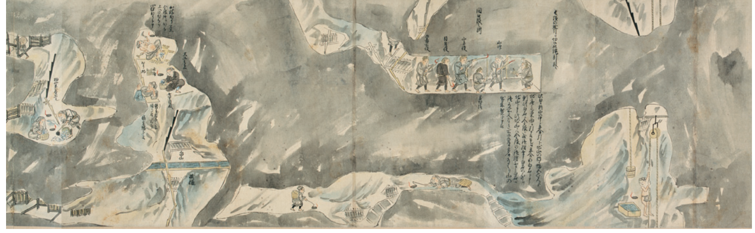
坑道内での様々な作業—間切り—
