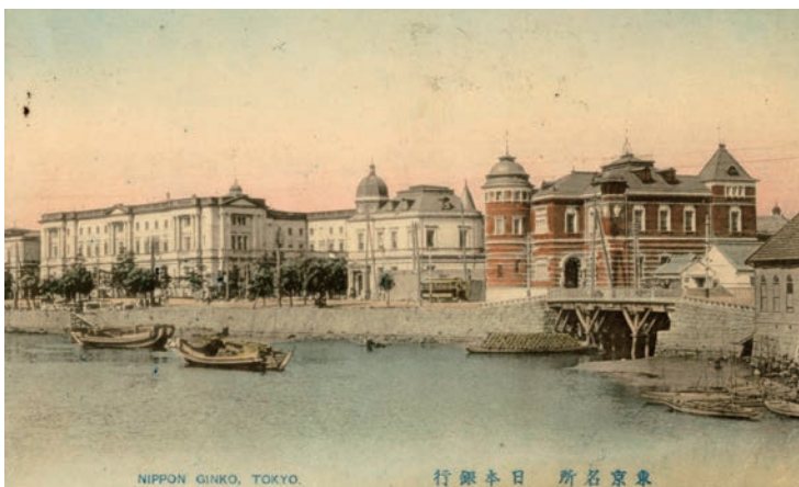
3つの辰野金吾建築と外堀 左から日本銀行本店本館、日本銀行南分館(1898年)、東京火災保険株式会社(1905年)。
