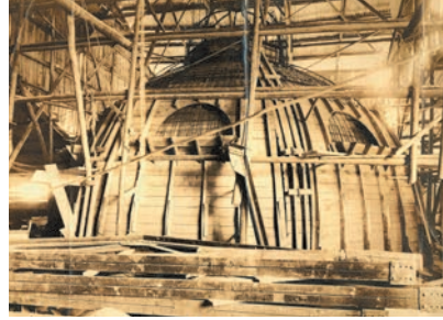
復旧工事中のドーム屋根
