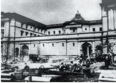
焼失したドーム屋根
