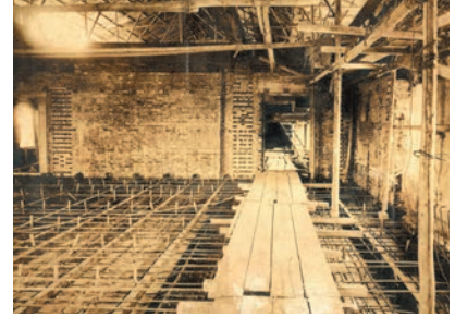
焼失した本館内の復旧工事
