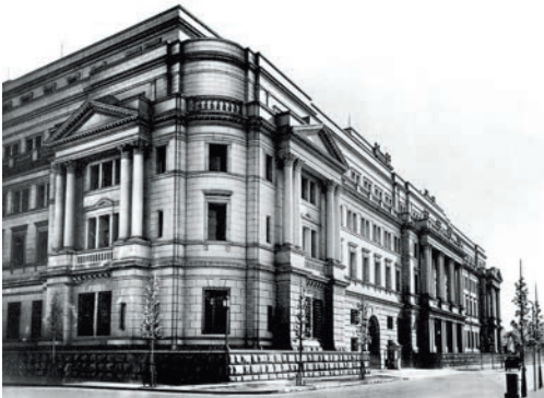
2号館(左・1935年竣工)と1号館(右奥)
