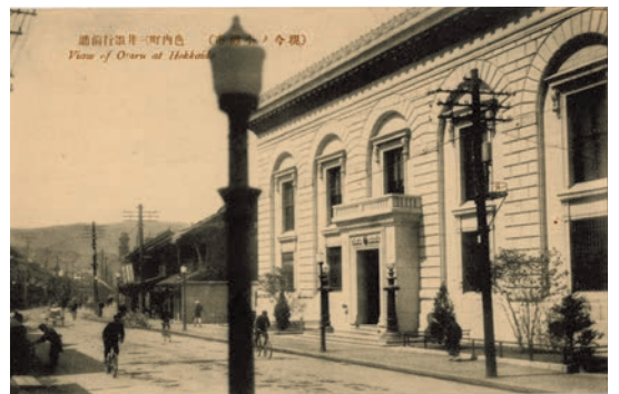
三井銀行小樽支店 小樽市指定有形文化財 1927年竣工。曾禰中條設計事務所設計。石積の外観であるが、構造は鉄骨鉄筋コンクリート造。 小樽芸術村 旧三井銀行小樽支店として公開。
