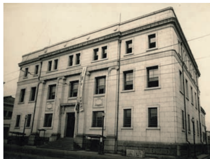
広島支店 1936年 広島市指定重要文化財 現・旧日本銀行広島支店
