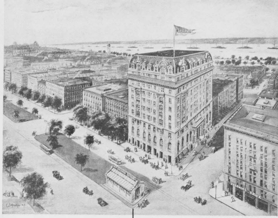
地下鉄、停車場
