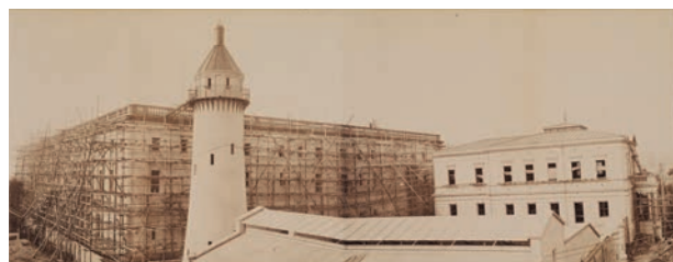
1895年8月14日 本館工事の途中から着工した西分館と機械室はほぼ完成している。
