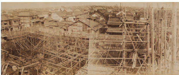
1892年10月30日 同年8月23日に着工した本館北側の機械室の地下工事。機械室は本館・西分館の熱源機械室として建てられた。
