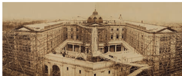
1895年8月14日 ドーム屋根が完成し、外壁頂部を飾るバラストレード等の銅板工事を施工中。
