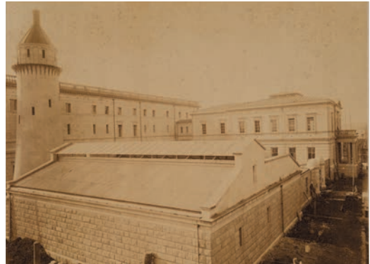
1896年1月18日 既に完成し、本館への熱源供給を待つ機械室と煙突。
