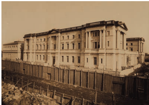
1896年1月18日 仮囲いに覆われ完成日を待つ本館の西側外観。
