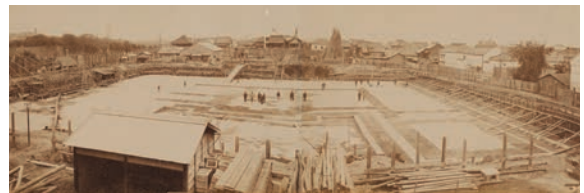
1891年5月2日 厚さ約2.6mの礎盤コンクリート工事が完了し、建物基礎となる煉瓦の根積み工事に着手した。
