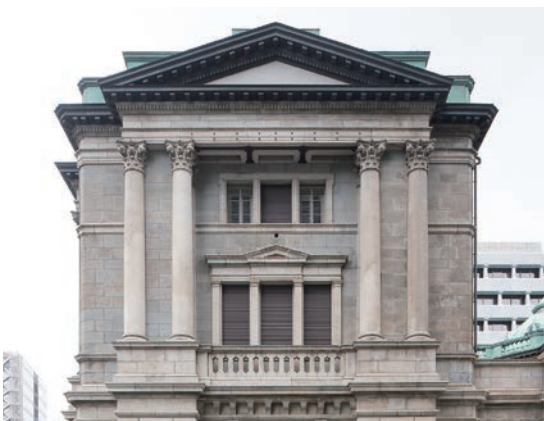
2・3階を貫く双柱の大オーダーとシンプルなペディメント
