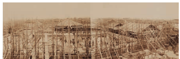
1892年3月10日 基礎式(定礎式)の様子。前年11月に予定されていたが10月末の濃尾地震により延期された。
