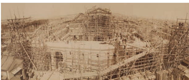
1893年9月11日 2階部分の石煉瓦積が進み、バルコニーに上がる工事用のスロープが設置された。9月16日に松方首相が現場を訪れている。
