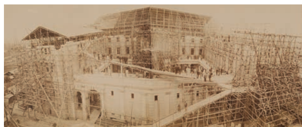
1894年5月18日 3階部分まで工事が進み、屋上に上がる工事用のスロープと仮屋根が設置された。この頃から木工事等の内装工事に着手している。
