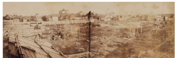
1890年9月26日 9月1日に地鎮祭を行い着工した。根切工事に先行して掘削位置を示す縄張りが施されている。
