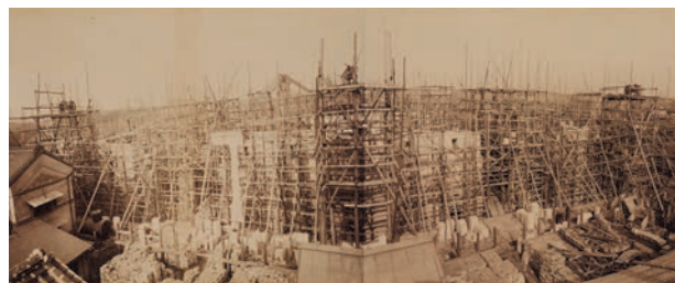
1893年1月8日 1階部分の石煉瓦積を終え、工事は2階部分へ移行した。
