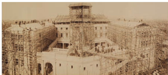
1894年12月5日 装飾部を含む外装の石積が完了し、屋根工事に合わせ仮屋根も外されている。ドーム屋根に上る工事用のスロープが設置された。
