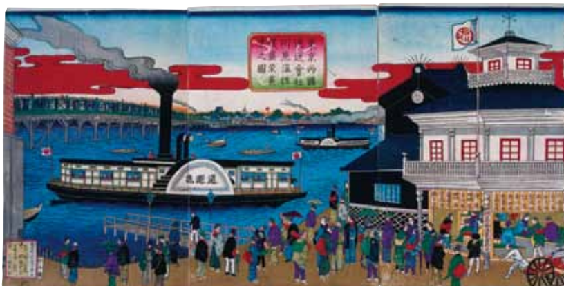
「東京両国通運会社川蒸気往復盛栄真景之図」 明治時代前期 900260
