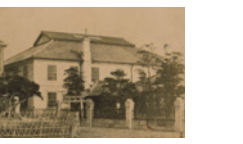
工事は、後に鹿鳴館の建築に従事する伊集院兼常が請け負った。
