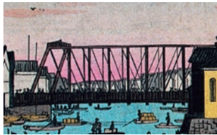
横側から見た鰐橋 橋本体がわずかに反っている様子がわかる。
