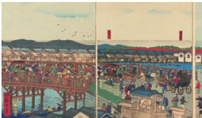
方杖トラス橋の日本橋 この改架時に、車道と歩道が設けられる。橋の中央に車道、その両側に歩道が設けられ、欄干により隔られている。
