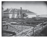
①基礎工事の様子と氷室（1878年頃か）
